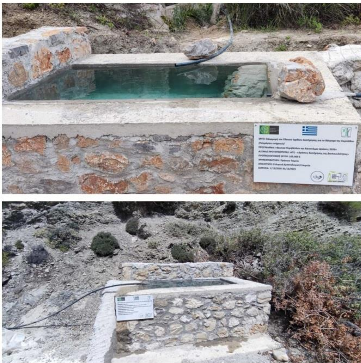
Εικόνα 2: Κατασκευή νέων λιμνίων-δεξαμενών στην Αχαμάντια (επάνω) και στο Νάτι (κάτω).
